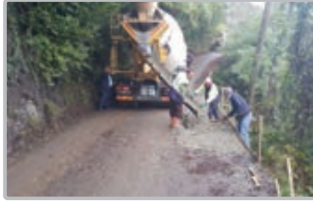
Demirtaş Mahallesi beton yol tamiri çalışması
