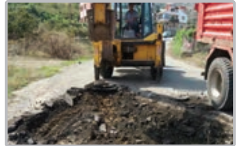
Söğütlü Mh. Mimar Sinan Cd. yol bakım çalışması
