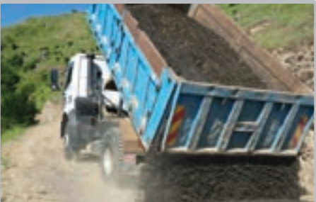
Demirtaş Mh. Yıldızlı Derecik Mh. bağlantı yolu malzemeli bakım yapılması
