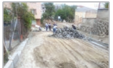
Yaylacık Mahallesi Cengiz Tosun Sokak Parke yapım çalışması
