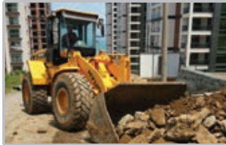
Söğütlü Mh. Mersinlik Cd. yol kenarlarındaki hafriyat ve moloz temizliği
