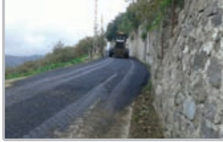
Demirtaş Mahallesi sıcak asfalt serildi
