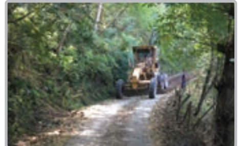
Derecik Mah. Karaman mevki Akasya Cad. malzemeli yol bakım çalışması yapılıyor
