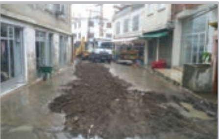
Derecik Mh. Merkez Çarşı Sk. kanalizasyon hattı parke yapımı
