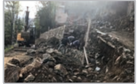
Ortaalan Mahallesi yol genişleme çalışması ve taş duvar çalışması
