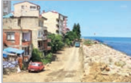
Darıca sahil tahkimatı arkası dolgu yapılıyor.
