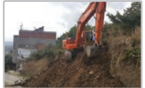
Yeni Mahalle Lazlar Sk. bağlantı yolu açılması çalışması
