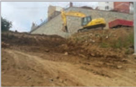
Söğütlü Mh. Fen Lisesi yolu yol düzenleme çalışması
