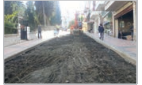
Dürbinar Mahallesi Milli Egemenlik Cad. yeni parke yapımı öncesinde eski parke sökümü
