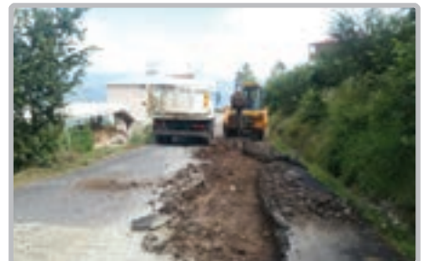
Dört Yol Mah. Erikli Şinoy Cad. asfalt bakımı yapılması
