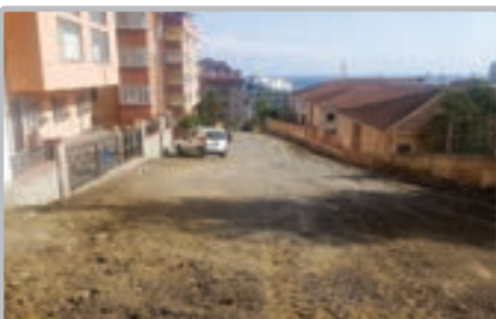
Yaylacık Mahallesi A. Cengiz Tosun Sk. parke öncesi yol temizliği
