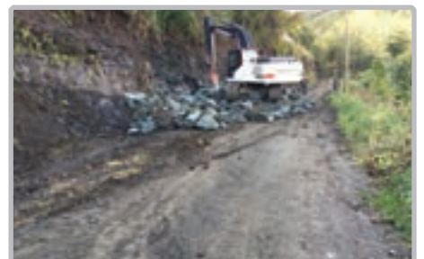
Mersin Mah. Seyranlık Mevkii yol genişleme çalışması
