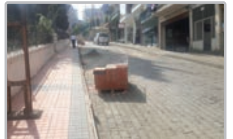
Dürbinar Mahallesi Milli Egemenlik Caddesi tretuvar ve parke çalışması
