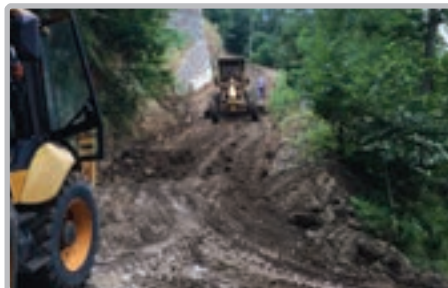
Akçaköy Mah. Ahmet Usta Sk. yol ve kanava temizliği çalışması
