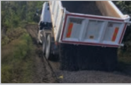
Çınarlık Mahallesi çakırlı mevki malzemeli yol bakımı çalışması
