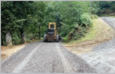
Koçlu Mahallesi malzemeli yol bakımı çalışması
