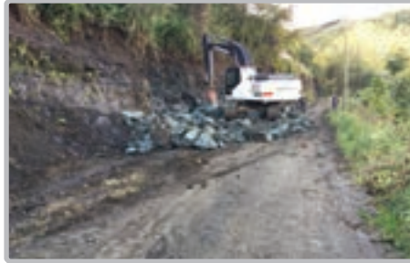
Mersin Mahallesi seyranlık mevki yol genişleme çalışması
