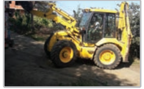
Karpınar Mah. kıran yolu dağ malzemeli yol bakım çalışması yapılıyor
