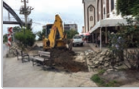
Akçakale Mh. Merkez Camii önü parke alt düzenleme yapılması
