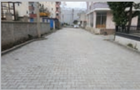
Söğütlü Mahallesi İnci Sokak parke yapıldı
