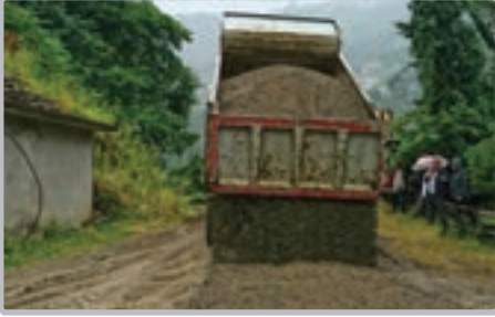
Adacık Mah. Benlitaş Karaağaç Sokak malzemeli yol bakım
