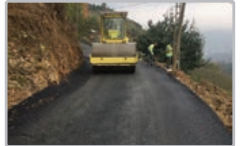
Uçarsu Mahallesi asfalt çalışması
