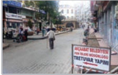
Dürbinar Mahallesi Lise Caddesi tretuvar düzenleme çalışması
