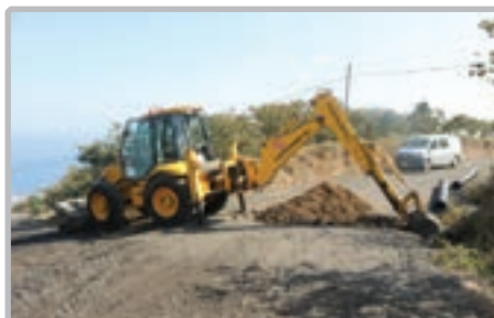
Söğütlü Mh. Esentepe Mevkii yüzey suyu çalışması
