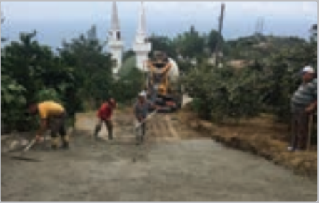
Darıca Mah. Gökçebel Kıran Mevkii camii yolu betonlaması yapıldı.
