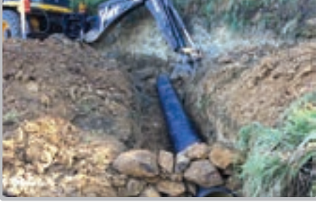
Akçaköy Mah. Ahmet Usta Sk. yüzeysuyu borusu konulması çalışması
