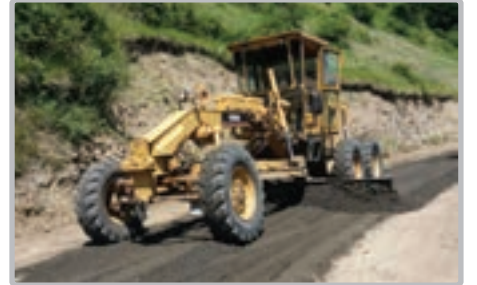
Demirtaş Mh. Yıldızlı Derecik Mh. bağlantı yolu malzemeli bakım yapılması
