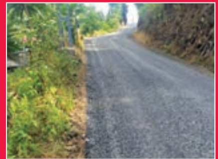
➤ Fındıklı Mh. Esentepe Mh. yolu asfalt öncesi yol kanava temizliği çalışması
