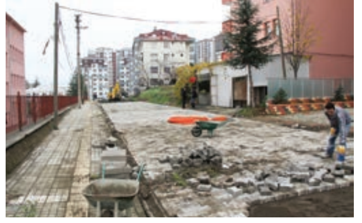
Söğütlü Mahallesi Çınar Sokak, Söğütlü İlkokulu arkasında 150 metre uzunluğundaki yolun parke kaplaması yapıldı.
