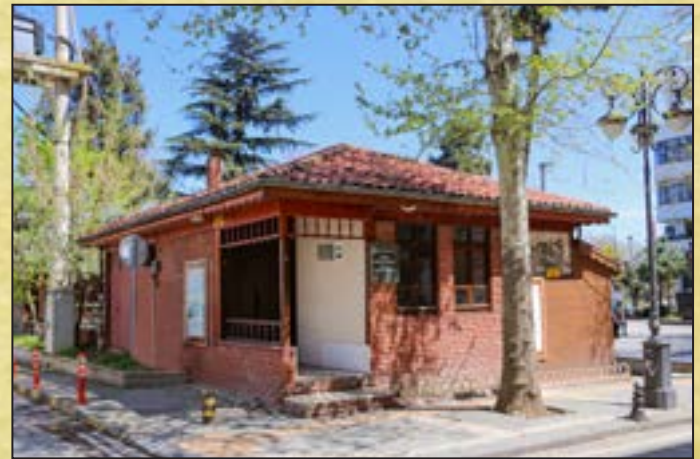
TURİZM DANIŞMA OFİSİNİN RESTORASYONU
