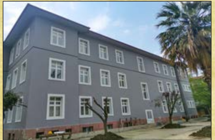
AKÇAABAT HÜKÜMET KONAĞI RESTORASYONU
