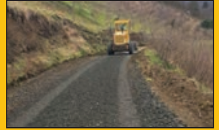
Darıca Mh. Karaçam-Cumhuriyet Cd. bağlantı yolu malzemeli yol bakımı
