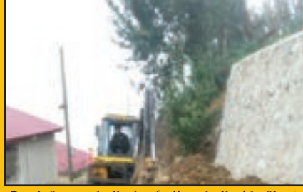
Bozdoğan mahallesi zaferli mahallesi bağlantı yolu yol malzemesi serildi
