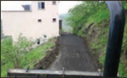
Akçakale Barış Cd. malzemeli yol bakımı
