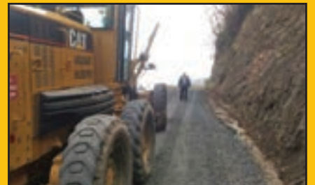
Akören yol malzemesi serildi
