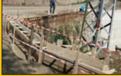
Derecik Mh. Uğurlu mevki Okul Sk. taş duvar üzeri korkuluk çalışması yapıldı
