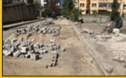
Söğütlü Mh. Eren Sk. doğalgaz geçişleri parke tamiratları
