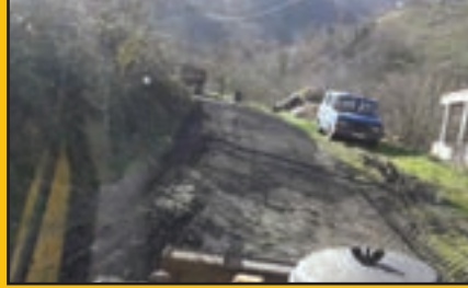
Adacık Taraklı Cd. malzemeli yol bakımı
