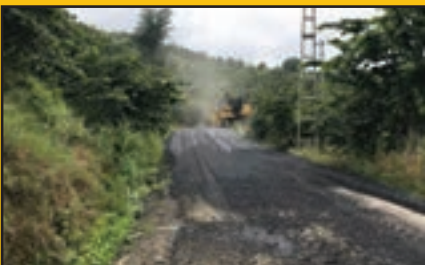
Kavaklı Mh. Kanuni Cd. sıcak asfalt seriliyor
