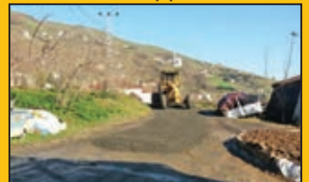
Derecik Mh. Uğurlu mevki Yeni Cd. malzemeli yol bakımı
