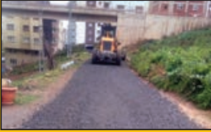
Söğütlü Mh. Narlı Sk. malzemeli yol bakımı
