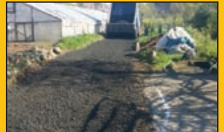
Yıldızlı Mh. Soguksu mevki malzemeli yol bakımı yapıldı
