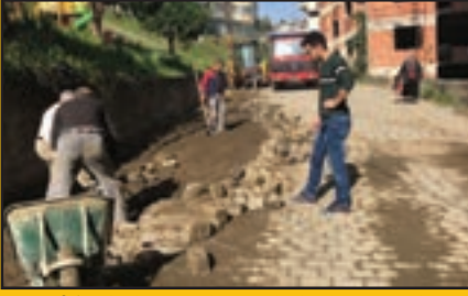
Nefsipulathane Mh. Bağdatlı Sk. taş parke tamirâtı
