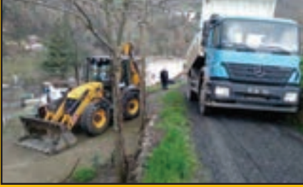
Doğanköy Mh. Şamlı Sk. malzemeli yol bakımı
