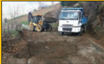
Derecik Mh. Çevreli mevki Yıldıztepe Sk. yol kanal temizleme
