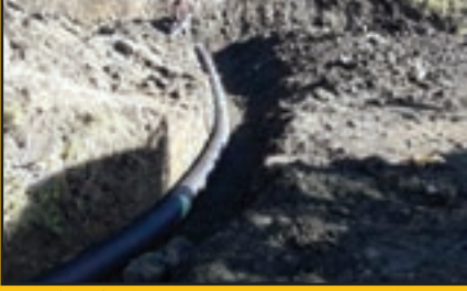
Çilekli Mh. yüzey suyu borusu koyuldu
