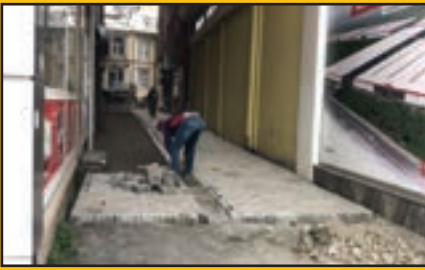
Nefsipulathane Mh. Avcılar Sk. parke çalışması
