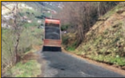
Uçarsu Mh. Kırzlık Mevki malzemeli yol bakımı
