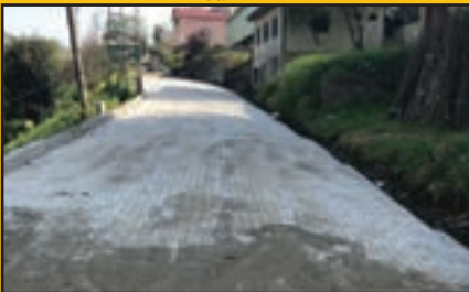
Işıklar Mh. santral yolu parke yapıyor
