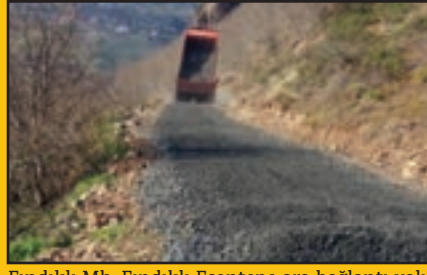
Fındıklı Mh. Fındıklı Esentepe ara bağlantı yolu malzemeli yol bakımı
