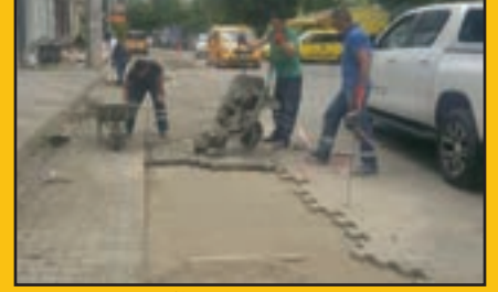
Söğütlü Mh. Fatih Sultan Mehmet Cd. Doğalgaz geçişleri parke tamiratları
