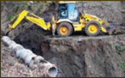
Adacık Selimiye Cd. Q800 lük beton büz koyuldu
