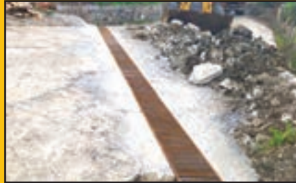
Akçakale Barış Cd. malzemeli yol bakımı
