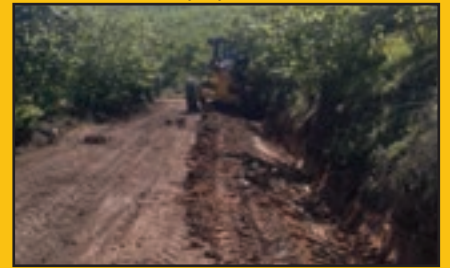
Özakdamar Mh. malzemeli yol bakımı çalışması
