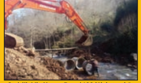
Cevizlik Mh. Uçarsu Deresi 100 lük beton büz ile dere geçişi yapıldı
