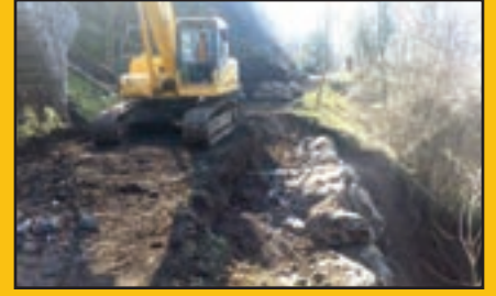
Doğanköy Mh. Dörtöl tepegören mevki bağlantı yolu taş tahkimat yapılması
