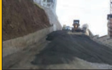
Yıldızlı Mh. Armada sitesi yolu malzemeli yol bakımı
