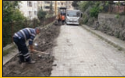
Söğütlü Mh. Hilal Sk. doğalgaz geçişleri üzeri parke tamiratları
