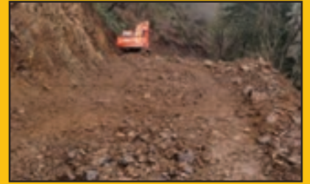
Uçarsu Mh. Çamlıca Mevki yeni yol açma çalışması
