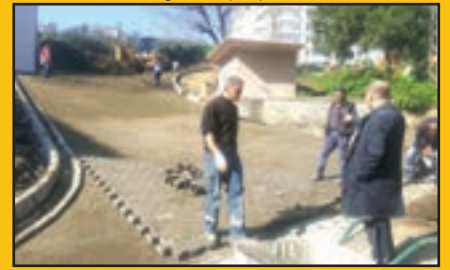
Nefsipulathane Mh. Yığcıoğlu Sk. parke çalışması
