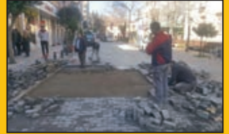
İnönü Cd. parke tamirat işleri yapılması
