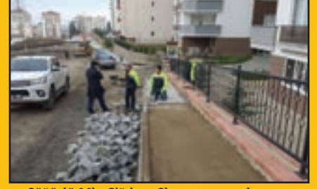
Söğütlü Mh. Çiğdem Sk. tretuvar çalışması
