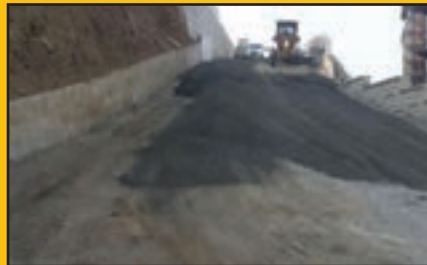
Yıldızlı Mh. Armada sitesi yolu malzemeli yol bakımı
