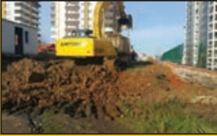
Söğütlü Mh. Hayat Sk. imar yolu yapımı
