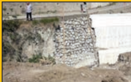
Derecik Mh. Uğurlu mevki Okul Sk. taş duvar yapıldı
