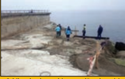
Sahil park sahası şehir terası düzenleme işi yapılması
