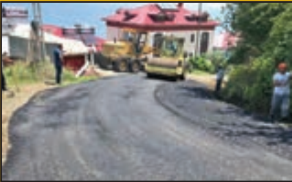
Akçakale Hasan Saka Cd. sıcak asfalt çalışması yapıldı
