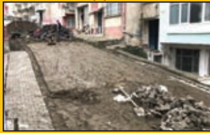
Nefsipulathane Mh. Bağdatlı Sk. doğal taş parke tamirâtı
