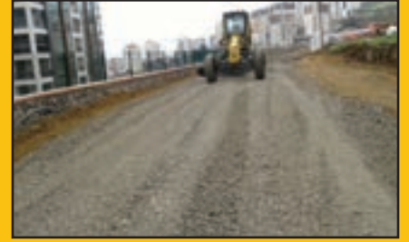
Söğütlü Mh. Mersinlik Cd. Hayat Sk yol malzemesi serilmesi
