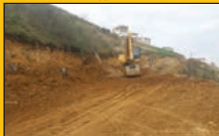
Kayalar Mh.-Yaylacık Mh. Zorosa mevki bağlantı yolu yol düzenleme çalışması
