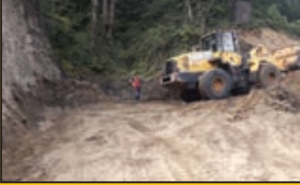
Adacık-Çamlıdere Mah bağlantı yolu
