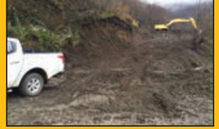
Mersin Mh. Kuru Küme Evleri mevki yol bağlantısı yapıldı
