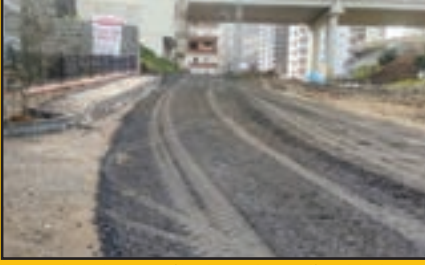
Söğütlü Mh. Derecik Sk. malzemeli yol bakımı
