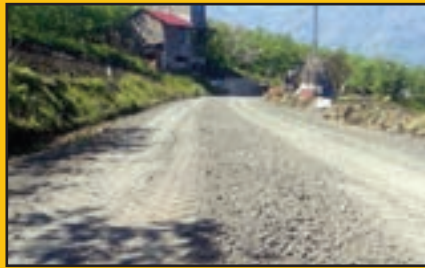
Özakdamar Mh. malzemeli yol bakımı çalışması
