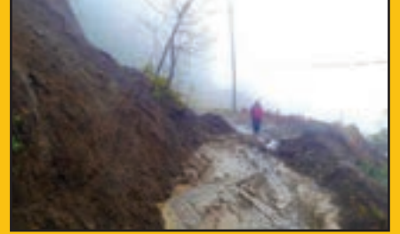
Adacık Esentepe Cd. heyelan temizleme çalışması
