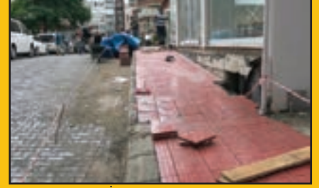
Çolaklı Mh. İnönü Cd. tretuvar çalışması
