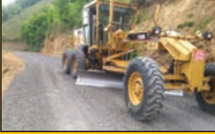
Demirci Mh. malzemeli yol bakımı yapılıyor
