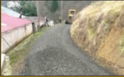
Fındıklı Mh. Tosunoğlu Sk malzemeli yol bakımı
