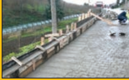
Çolaklı Mh. Dere Sk. yol duvarı çalışması
