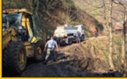
Mersin Mh. Kabaoğlu mevki yüzey suyu borusu açıldı
