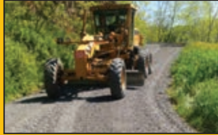
Helvacı Mh. malzemeli yol bakımı
