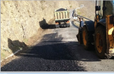
Sivriburun yolu asfalt yama çalışması
