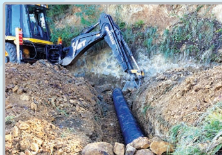
Akçaköy Mh. Ahmet Usta Sokak yüzeysuyu borusu konulması
