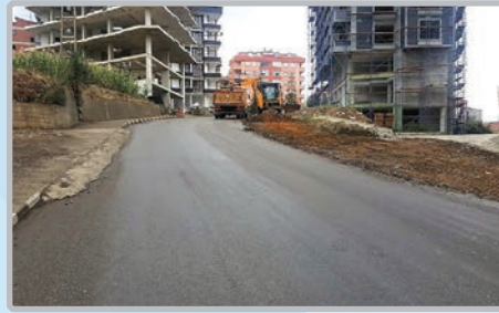
Yaylacık Mahallesi Akçaabat Caddesi yol genişleme çalışması
