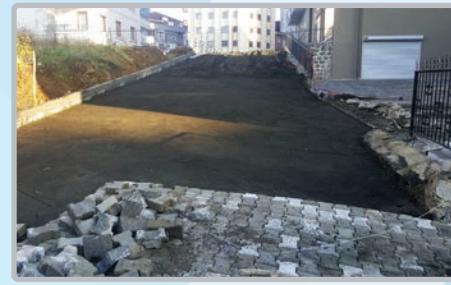
Yaylacık Mahallesi İlkadım Caddesi bağlantı yolu parke çalışması
