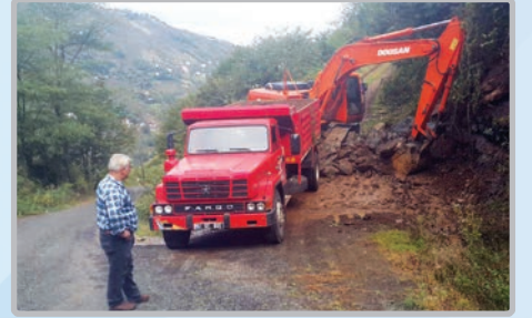
Fındıklı Mahallesi-Esentepe Mahallesi bağlantı yolu yol genişleme çalışması
