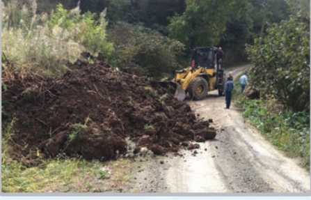
Derecik Mahallesi Karaman mevkii Karaman Cd. heyelan kaldırma çalışması
