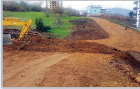
Söğütlü Mahallesi Şehzade Sokak beton büz çalışması
