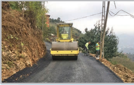
Uçarsu Mahallesi sıcak asfalt serme çalışması
