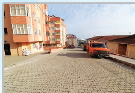
Yaylacık Mahallesi A. Cengiz Tosun Sokak yol trotuar çalışması
