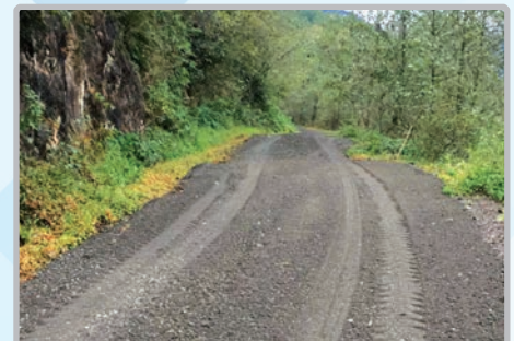
Çukurca Mahallesi Çakıroğlu yolu malzemeli yol bakımı
