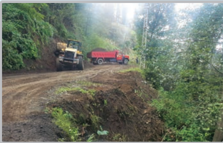
Ağaçlı Mahallesi malzemeli yol bakım çalışması
