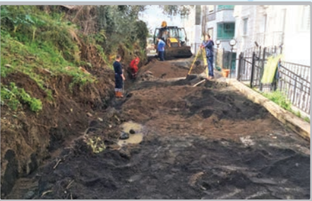
Mersin Mahallesi Sahil Caddesi yüzey suyu borusu yerleştirilmesi
