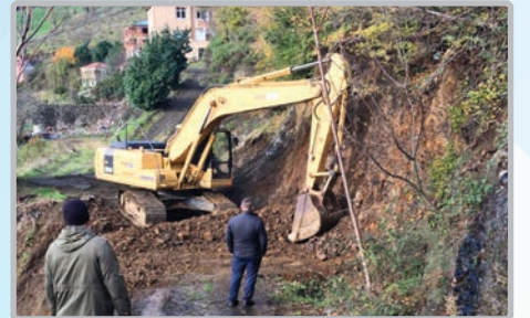
Mersin Mahallesi Güneşli Caddesi yol genişleme çalışması
