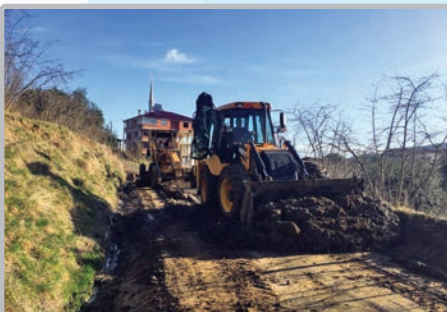
Akçaköy Mahallesi Uzunali ve Kalecik Sokak yol ve kanava temizliği
