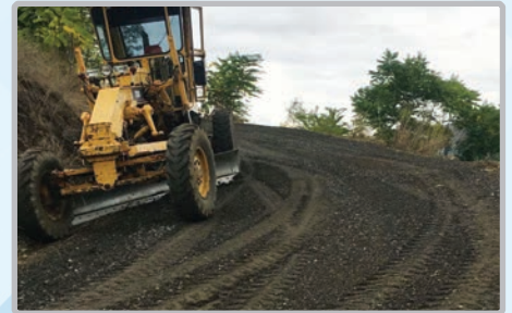
Akçaköy Mahallesi Ahmet Sk. malzemeli yol bakımı
