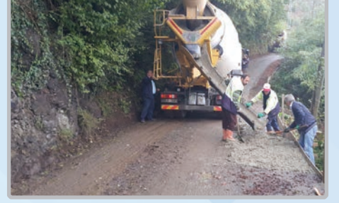
Demirtaş Mahallesi beton yol tamiri
