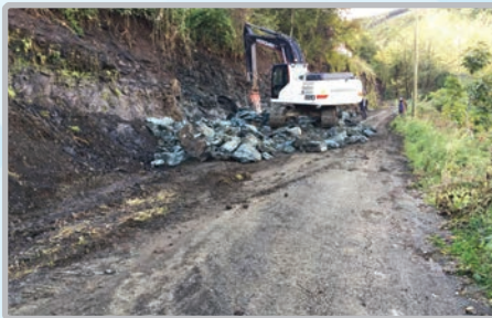
Mersin Mahallesi seyranlıklar mevki yol genişleme çalışması
