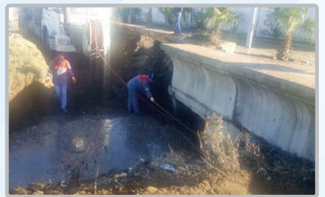
Yaylacık Mahallesi 100.yıl mevki yüzey suyu kanalı temizlik çalışması yapıldı
