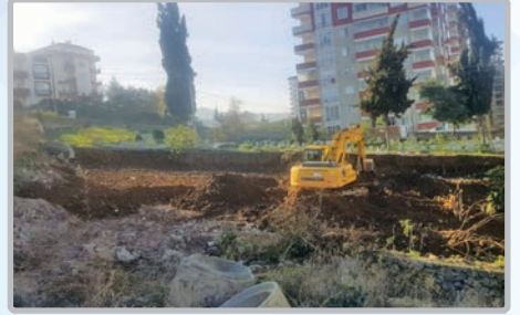
Söğütlü Mahallesi Soğuksu Deresi kenarı çevre düzenleme çalışması
