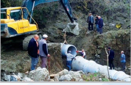
Darica Mahallesi Karaçam mevki Q1000 lik yüzey suyu borusu koyulması
