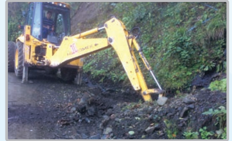
Ağaçlı Mahallesi büz ağızlarının temizliği
