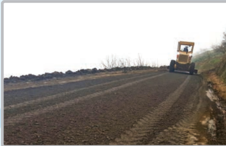
Mersin Mah. Üzümlü Çayırılık mevki malzemeli yol bakımı
