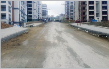
Söğütlü Mahallesi Mersinlik Caddesi trotuar yapılması
