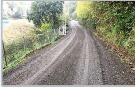
Karaman mevkii Çabuklu Sokaka malzemeli yol bakımı
