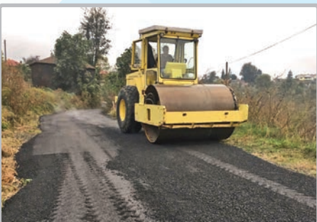
Yıldızlı Mahallesi Mavra sıcak asfalt serme çalışması
