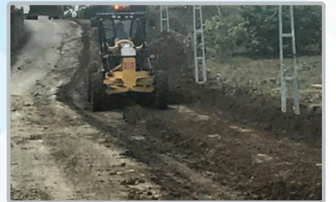
Sartaş Mahallesi Değirmenli Sokak asfalt öncesi yol düzenleme çalışması
