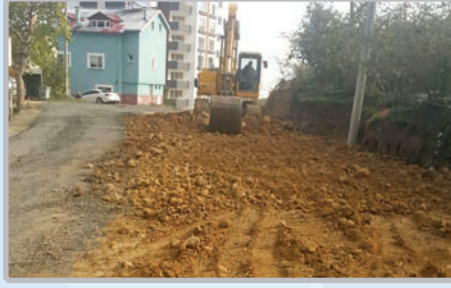
Söğütlü Mahallesi Altınpark Sitesi yolu yol dolgu çalışması
