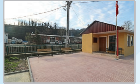
Kavaklı Mahallesi muhtarlık binası yapıldı
